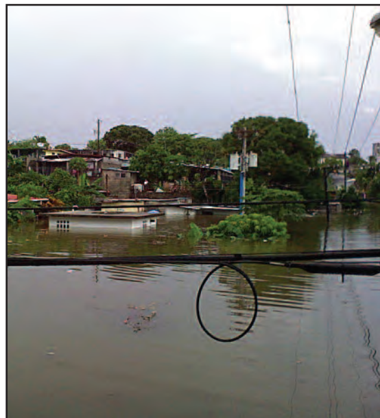
Barriada Nueve de Enero de San Miguelito, inundada por las aguas pluviales en mayo de 2007, al obstruirse con desperdicios de una alcantarilla de dos metros de diámetro. Foto Carlos Augusto Villalaz Díaz.
