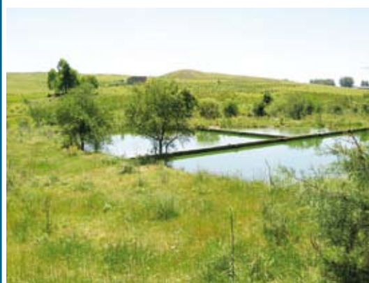
Figura 96. Laguna de tratamiento de MEVIR I
