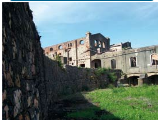
Figura 27. Vista del edificio de la antigua usina del "Cuñapirú"
