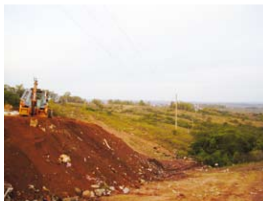
Figura 46. Adecuación de la terraza de disposición final de los residuos, parte del mantenimiento realizado en 2009 por la empresa Súper K
