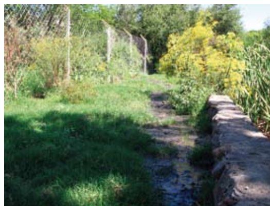
Figura 31. Esguerrimiento de aguas residuales por el borde del sistema de tratamiento, MEVIR I
