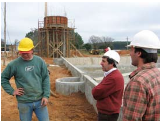
Figura 69. Obras de la planta de tratamiento de OSE
