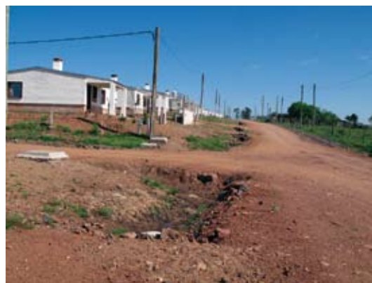
Figura 22. Vista de las casas de MEVIR II
