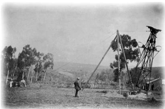
Figura 26. Momento de la instalación de la torre del aerocarril, 1901
