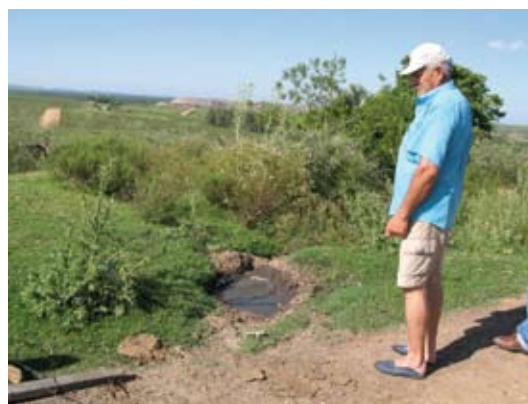
Figura 37. Predio donde se vierten las aguas cloacales recogidas por barométrica
