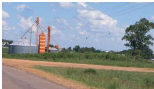
Figura 86. Uno de los silos en la entrada de Vichadero
