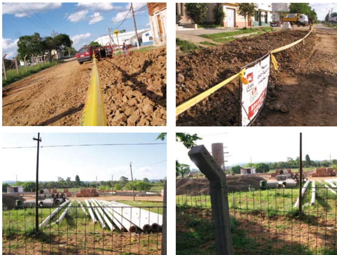
Figura 19. Obras de redes y planta de tratamiento de efluentes en Tranqueras
