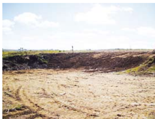
Figura 106. Zona de disposición final de la trinchera sanitaria al 2009
