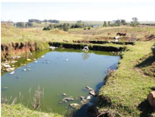
Figura 101. Piletas de tratamiento en la trinchera sanitaria (sin mantenimiento, 2008)
