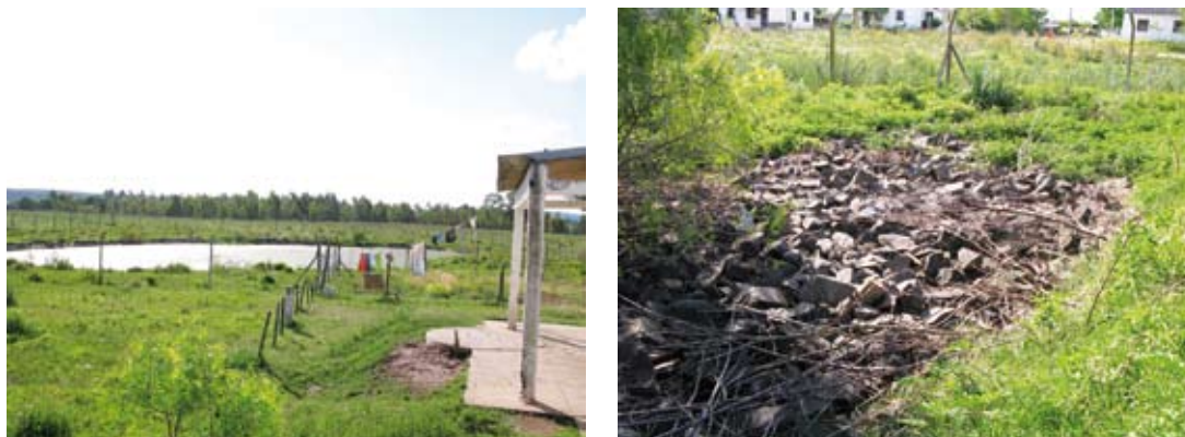
Figura 16. Sistemas de tratamiento de MEVIR III y IV de Tranqueras
