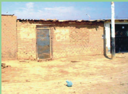
Vivienda de material de adobe
