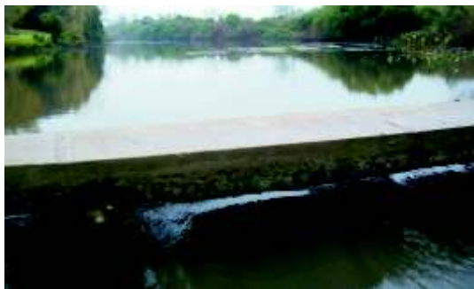
Foto 10. Vista de Arroyo Colla y Paso Arballo. Autor: Carlos Pérez Arrarte.
