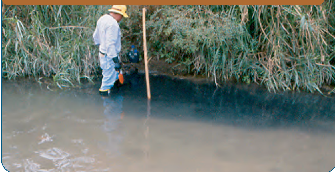
Río Teaone remoción de sedimentos contaminados
