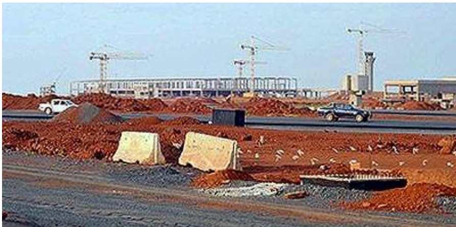
Figure 15.4 : Vue des travaux de construction de l'AIBD 56
