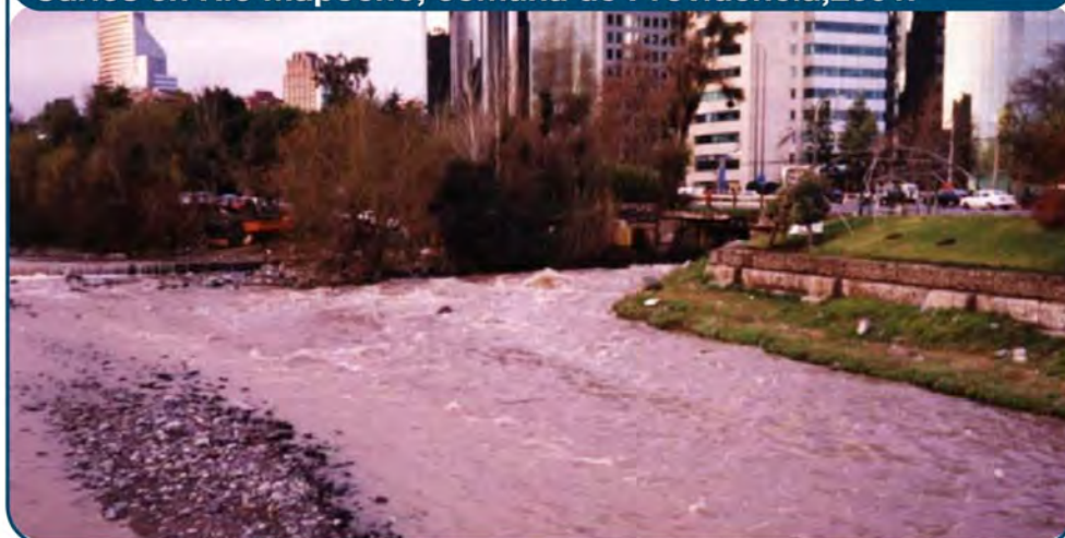
Figura N° 3.6: Imagen de la desembocadura del Canal San Carlos en Río Mapocho, comuna de Providencia, 2001.
