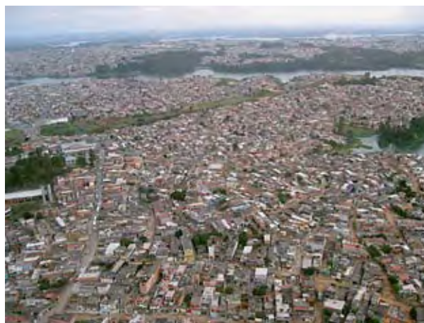
Ocupação irregular em área de mananciais - Distrito Grajaú - Zona Sul (Foto: Acervo DUC/SVMA)
