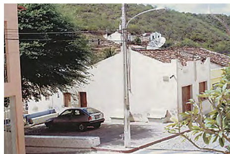
Fotografia 3.30 – Praça utilizada como estacionamento
