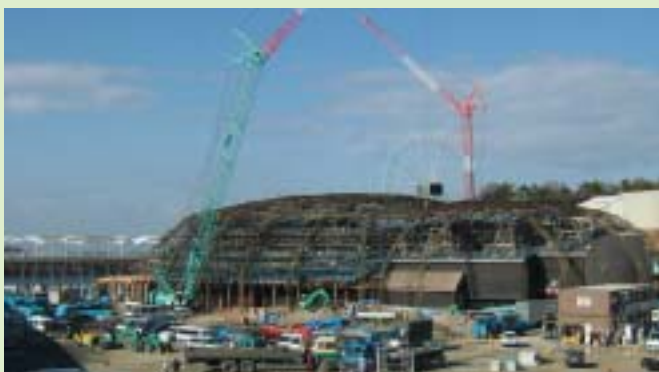
El pabellón japonés en construcción.
