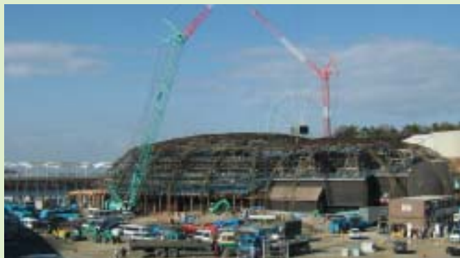
Pavillon japonais en construction.
