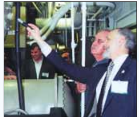
Expertos ambientales verifican el enfriador S-Series EarthWise™ CenTraVac durante el foro de Tecnologías Mundiales.
