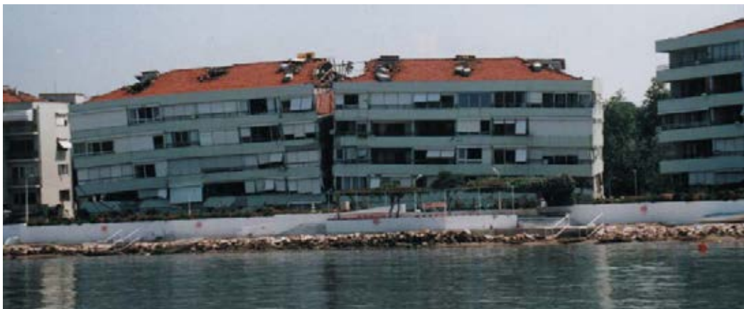
Edificio de apartamentos partido en dos por el terremoto de 1999 en Izmit, Turquía.
