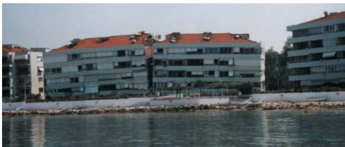
В 1999 году во время землетрясения в г. Измит (Турция) жилой дом разломился надвое
