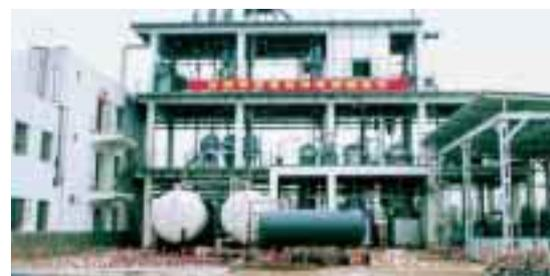
*Primera planta piloto de HFC-134a para China de Xi'an Jinzhu Chemical Industry Co. Ltd encargada en marzo de 1999. El proceso de esta planta—que tiene una capacidad de 200 toneladas por año—ha sido desarrollado por el Modern Chemistry Research Institute de Xi'an, y China tiene planes para otra planta de HFC-134a con una capacidad de 5000 toneladas, que se desarrollará en breve.*
