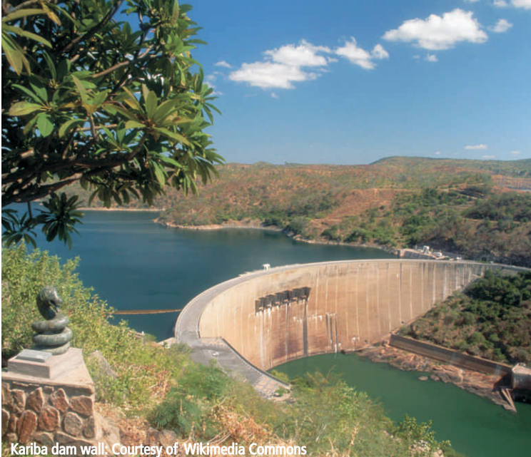
Kariba dam wall: Courtesy of Wikimedia Commons
