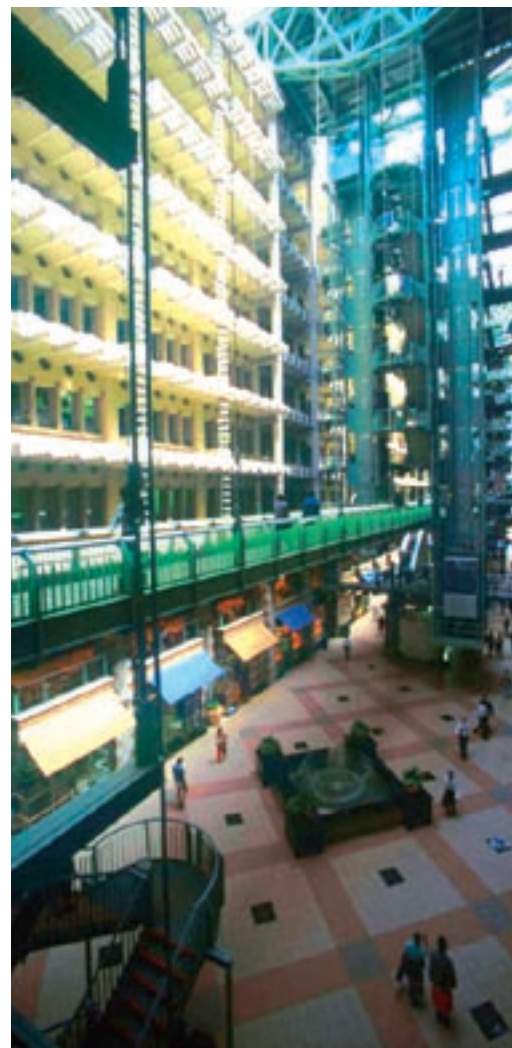
L'Eastgate Building dispose d'un système de climatisation passive s'inspirant des modèles trouvés dans la nature.
