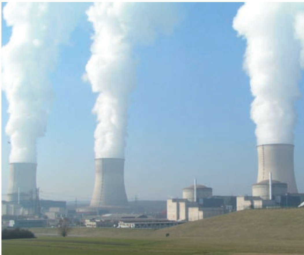
Complexe de production d'énergie nucléaire du Tricastin dans le sud-est de la France
