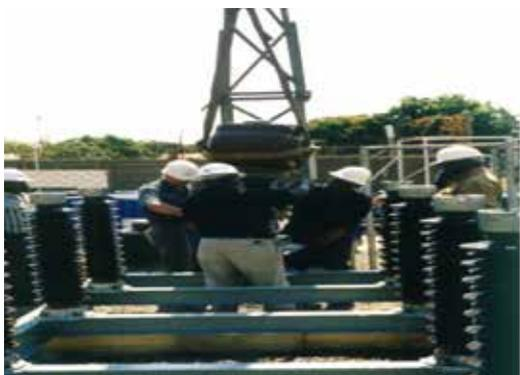
Photo 55 : Démontage d'une batterie de condensateurs
