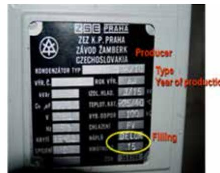
Photo 13 : Identification du fluide d'un condensateur
