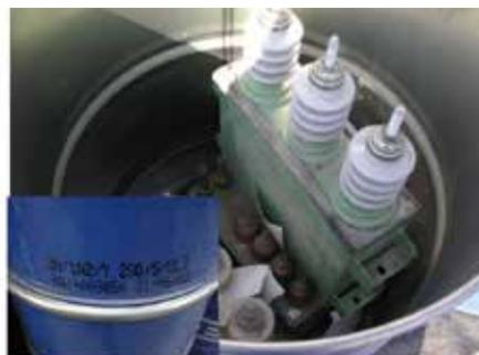
Photo 68 : Condensateurs contenant des PCB dans un fût en acier
