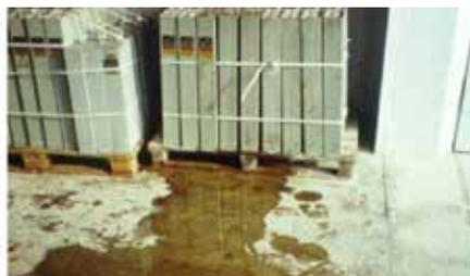
Photo 85: Mauvais exemple II (absence de bac récepteurs)
