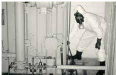
Photo 53 : Purge d'un transformateur contenant des PCB
