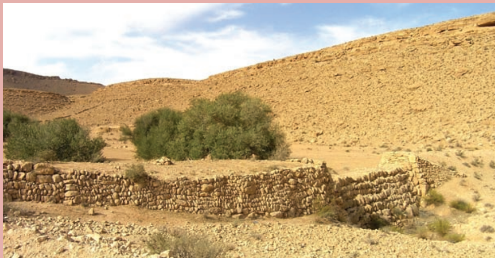
Традиционное террасирование для выхода воды и управления склоновыми стоками возле г. Татуин в Южном Тунисе.
