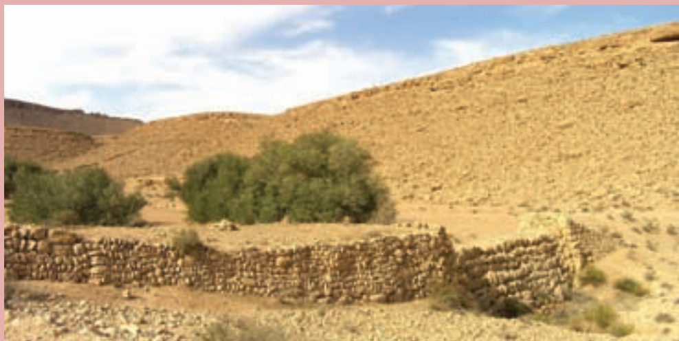
在突尼斯南部靠近塔塔维纳省(Tataouine)用于收集水和控制地表漫流的传统梯田。
