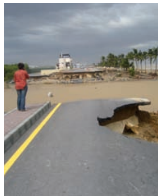
Следы разрушений, нанесенных циклоном «Гону», – затопленные улицы, вышедшие из строя линии электропередач, поврежденная система водоснабжения и подорванная береговая инфраструктура. Источник: Dilip Correa/ Daijiworld.com
