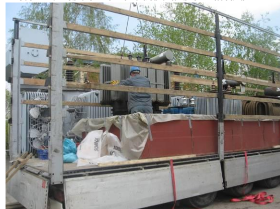
Photo 72 : Positionnement des transformateurs
