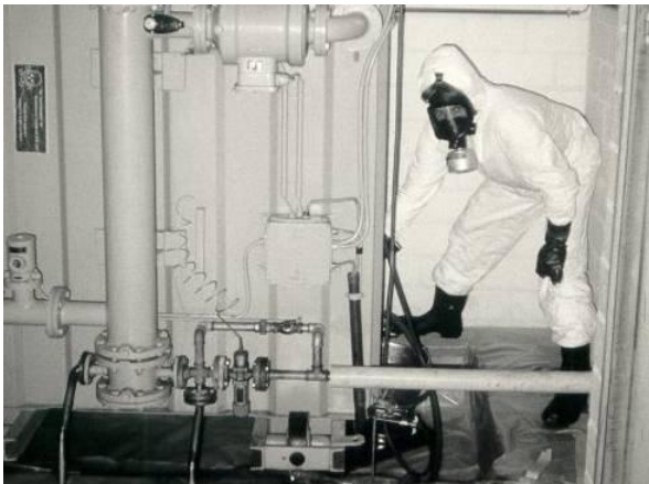
Photo 53 : Purge d'un transformateur contenant des PCB
