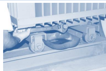
Ouvrir le robinet / la valve de vidange (habituellement par le technicien local)
