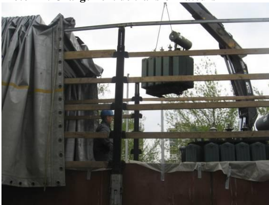
Photo 71 : Chargement de transformateurs
