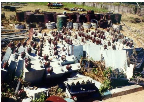
Photo 84 : Mauvais exemple I (entreposage à ciel ouvert)
