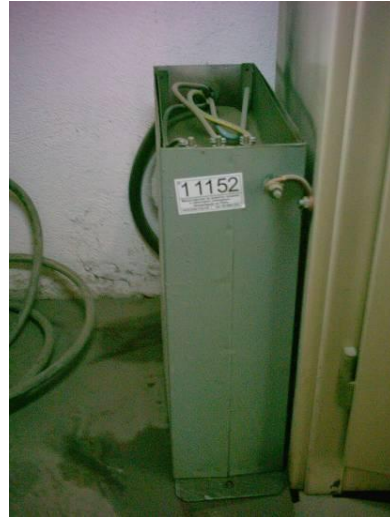
Photo 56 : Condensateur inventorié et étiqueté
