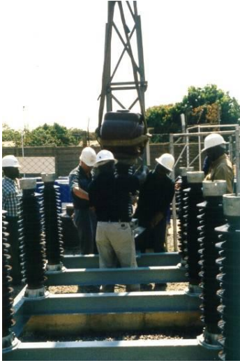
Photo 55 : Démontage d'une batterie de condensateurs
