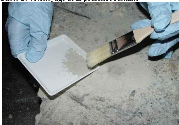
Photo 20 : Nettoyage de la poussière restante
