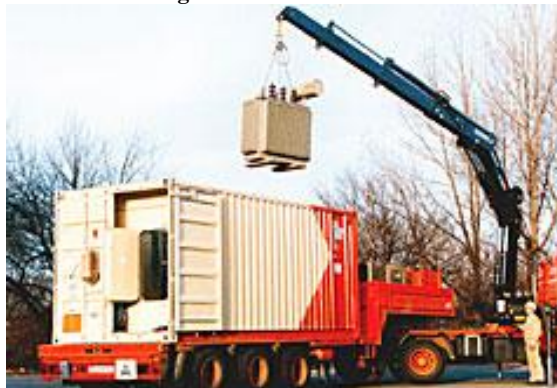
Photo 100 : Chargement de transformateurs
