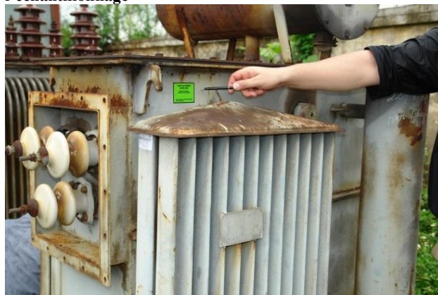
Photo 16 : Apposition de vignettes au cours de l'échantillonnage et d'une vignette finale à l'issue de l'échantillonnage
