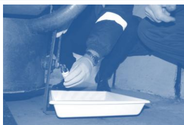
Placer un bac récepteur sous le robinet de vidange, en portant des gants et des lunettes de protection
