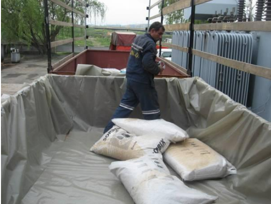
Photo 69 : Préparation du transport d'un transformateur contenant des PCB
