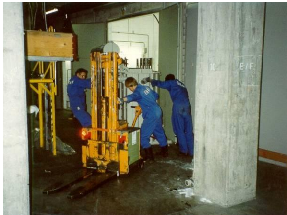
Photo 54 : Mise hors service d'un transformateur intact contenant des PCB
