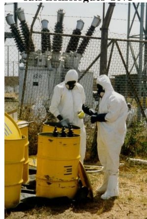
Photo 58 : Conditionnement de bouchons fuyants dans des fûts homologués ONU
