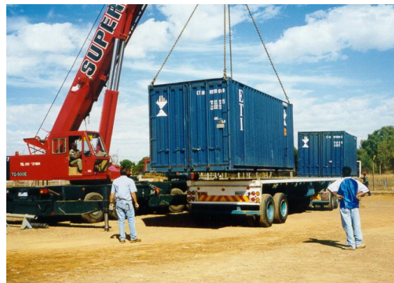
Photo 98 : Levage et positionnement des conteneurs sur la plateforme du camion
