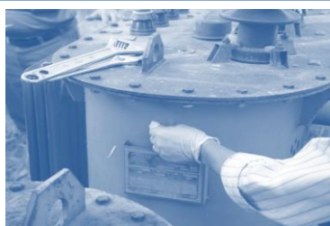
Apposer la vignette d'échantillonnage sur le transformateur (après avoir nettoyé la surface)
