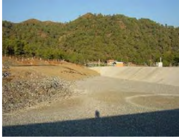
Photo 5 Réservoir de stockage des ordures d'Ortaca
