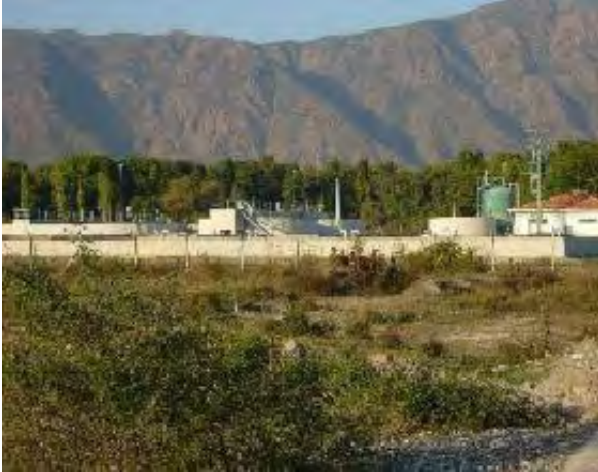
Photo 1 Station de traitement des eaux usées de Köyceğiz
