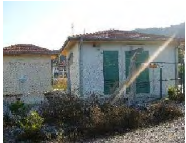
Photo 4 Bassin de recueillement d'eau potable de Dalyan
