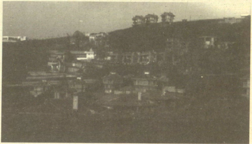
Constructions sauvages dans la banlieue d'Istanbul (archives DHKD)
