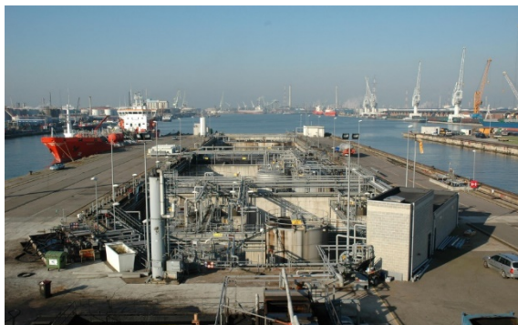
Installation de réception et traitement fixe (Crédits photographiques : MAC 2 Anvers, Belgique)
