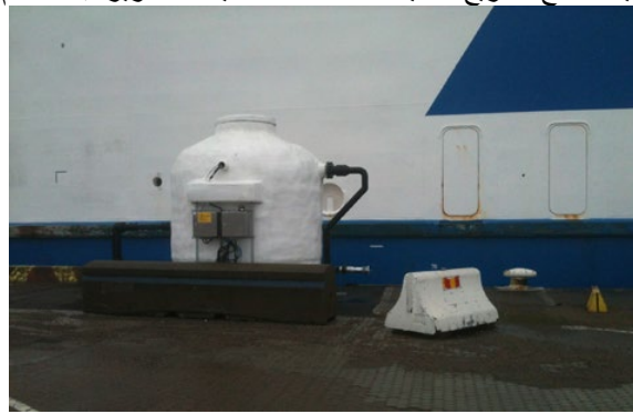
جمع مياه المجاري في ميناء تريلبورغ (السويد) (مرجع الصورة): Clean Baltic
