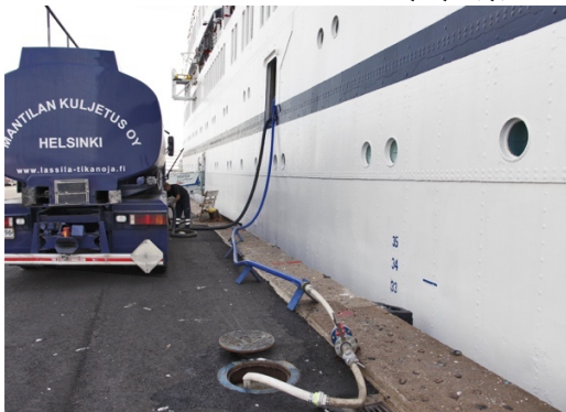
جمع مياه المجاري في ميناء هلسنكي (فنلندا) (مراجع الصورة):
