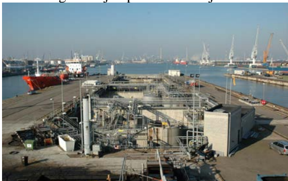
Instalación fija de recepción y tratamiento (Foto:
