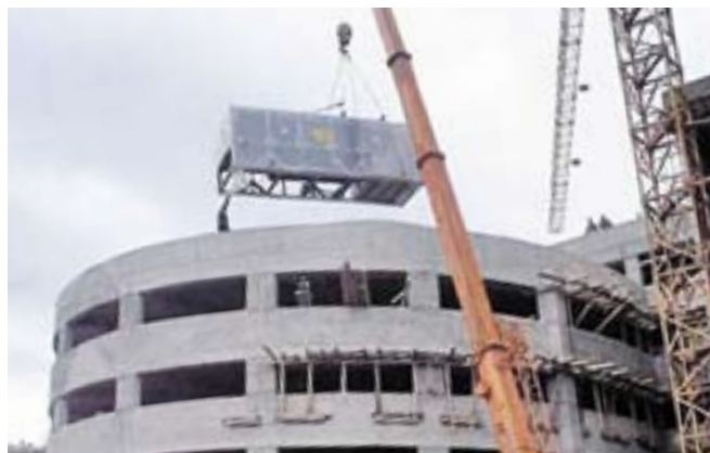
Avaz Twist Tower chiller installation Монтаж чиллера в небоскребе Avaz Twist Tower
