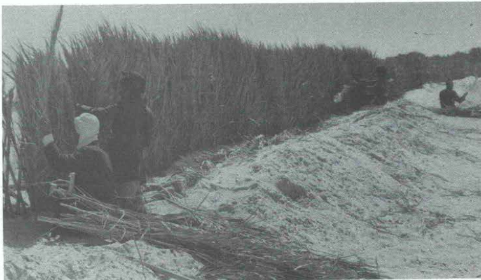
Les dunes de sable peuvent être fixées par les feuilles de palmiers. (UNEP/T. Farkas).
