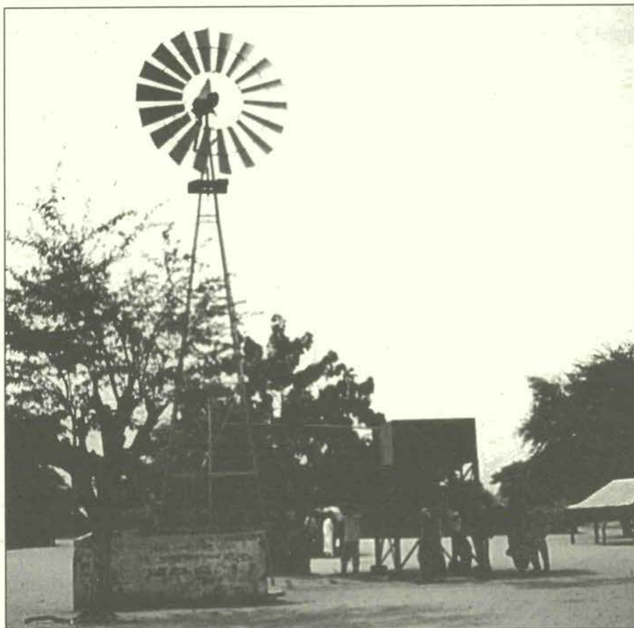
Figure 3.- Aeolian water pump at Par Cisse
