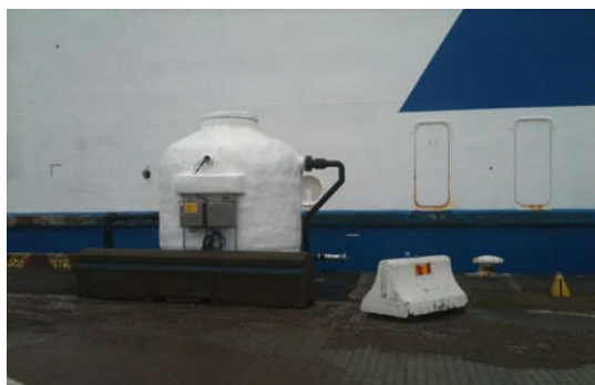
Collecte d'eaux usées dans le port de Trelleborg (Suède) (Crédits photographiques : Clean Baltic Sea Shipping)
