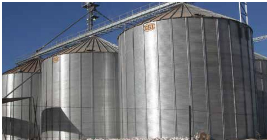
Silos à grains (Zambie)
