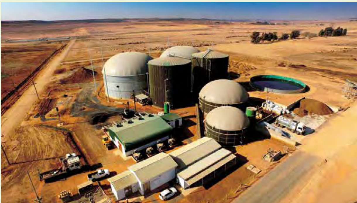
Usine de biogaz de Bio2Watt, Bronkhorspruit
