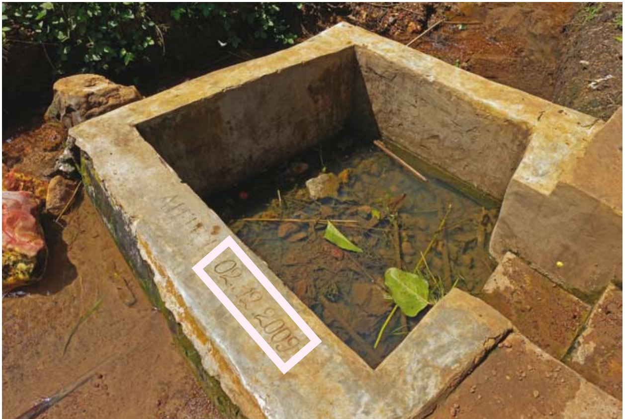
Bien qu'elle ait été construite récemment en février 2009 dans le village de Boka, le SNHR a ordonné que cette « spring box » soit détruite pour préserver la santé de la population (province de Bandundu)
