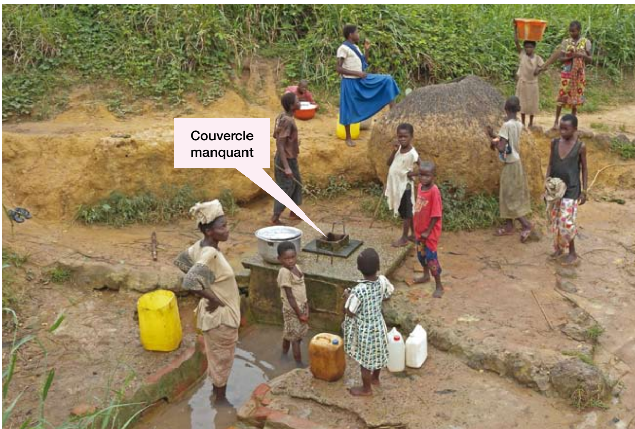
Le couvercle manquant rend la contamination inévitable. On note aussi l'absence de tranchée et de barrière autour du site pour protéger la source de la pollution (Source de Denge, Libenge, province de l'Equateur)
