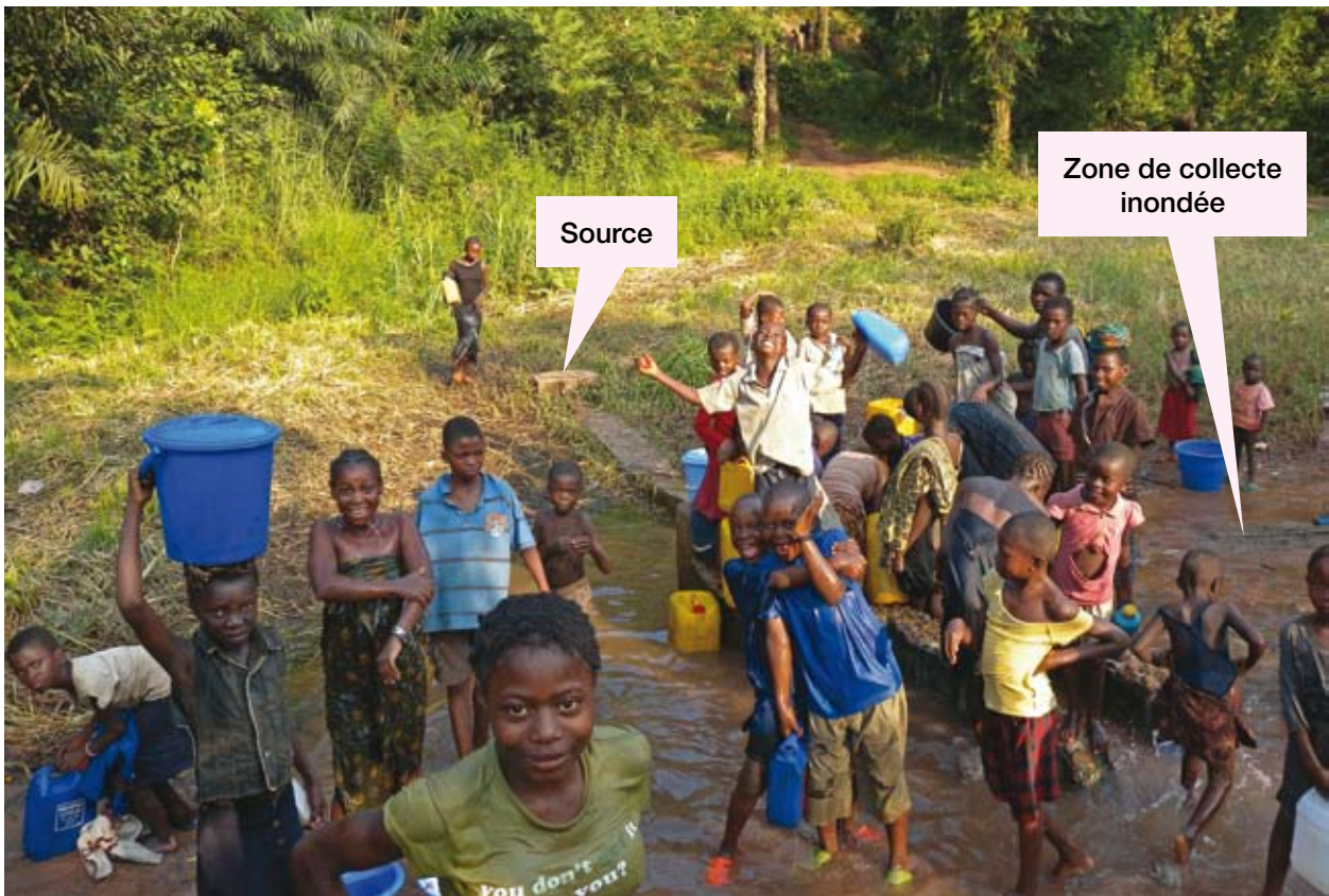
Les eaux stagnantes et le bas débit du courant sont deux indicateurs d'un aménagement mal réalisé. Source de Moubaka à Kikwit. Province de Bandundu
