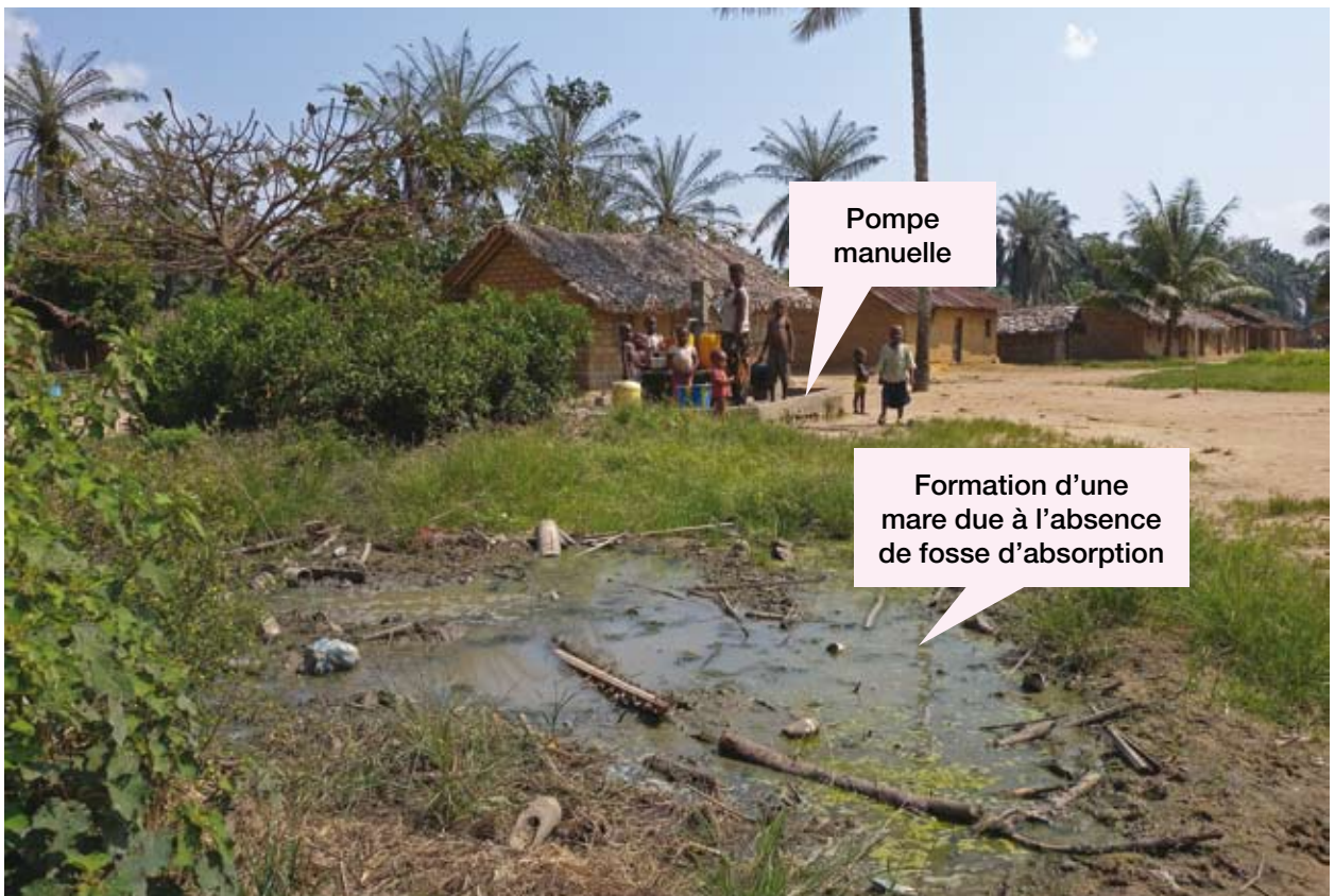
Sans canal d'évacuation pour l'eau pompée en surplus, les eaux stagnantes s'accumulent et favorisent l'apparition de maladies infectieuses (village de Bilundu, province de Maniema)
