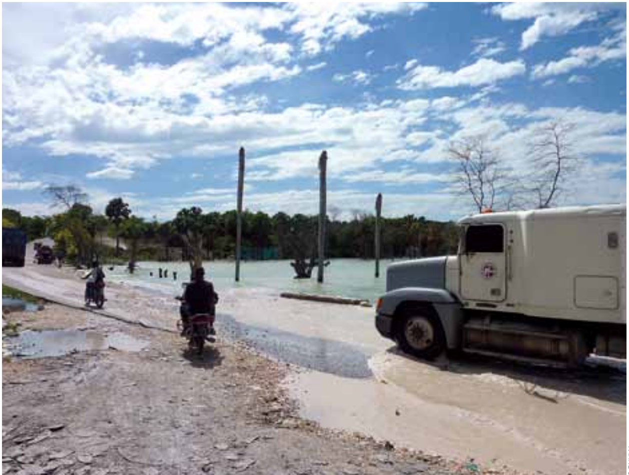
El camino principal que conecta Port-au-Prince y Santo Domingo ha sido elevado varias veces a lo largo de las orillas del Lago Azuei; sin embargo, esta solución es solo temporal dado que el nivel de las aguas sigue en aumento.
