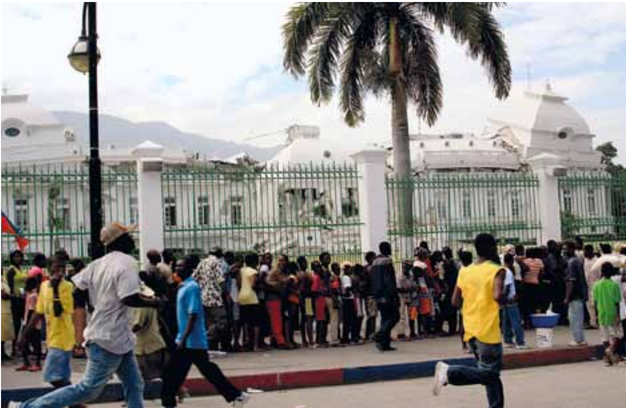
El terremoto que afectó a Haití en Enero del 2012 causó daños sin precedente en la capital Port-au-Prince, cobrando la vida de 225,000 personas.
