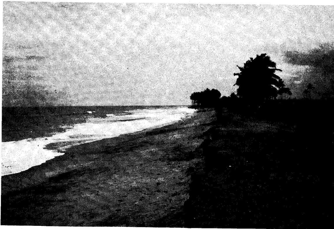
Fig. 1.11. - Recul du rivage avec destruction de la route côtière à l'ouest de Kpémé (Togo) - (Quélenec, 1984).
