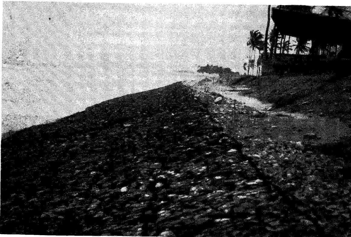
Fig. 5.2. - Revêtement en gabions du haut estran d'une plage en recul près d'Accra (Ghana) - (Ibé).
