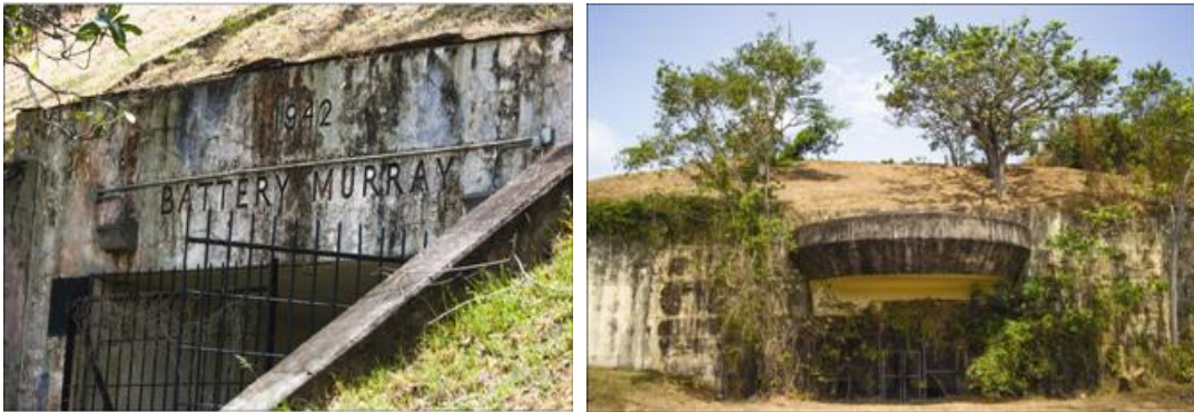
Bunkers ubicados en el área económica especial, Panamá Pacífico
