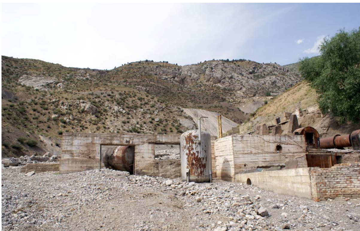
Рис. 31 Чаувай: разрушенная вращающаяся печь и завод (2008 г.)
