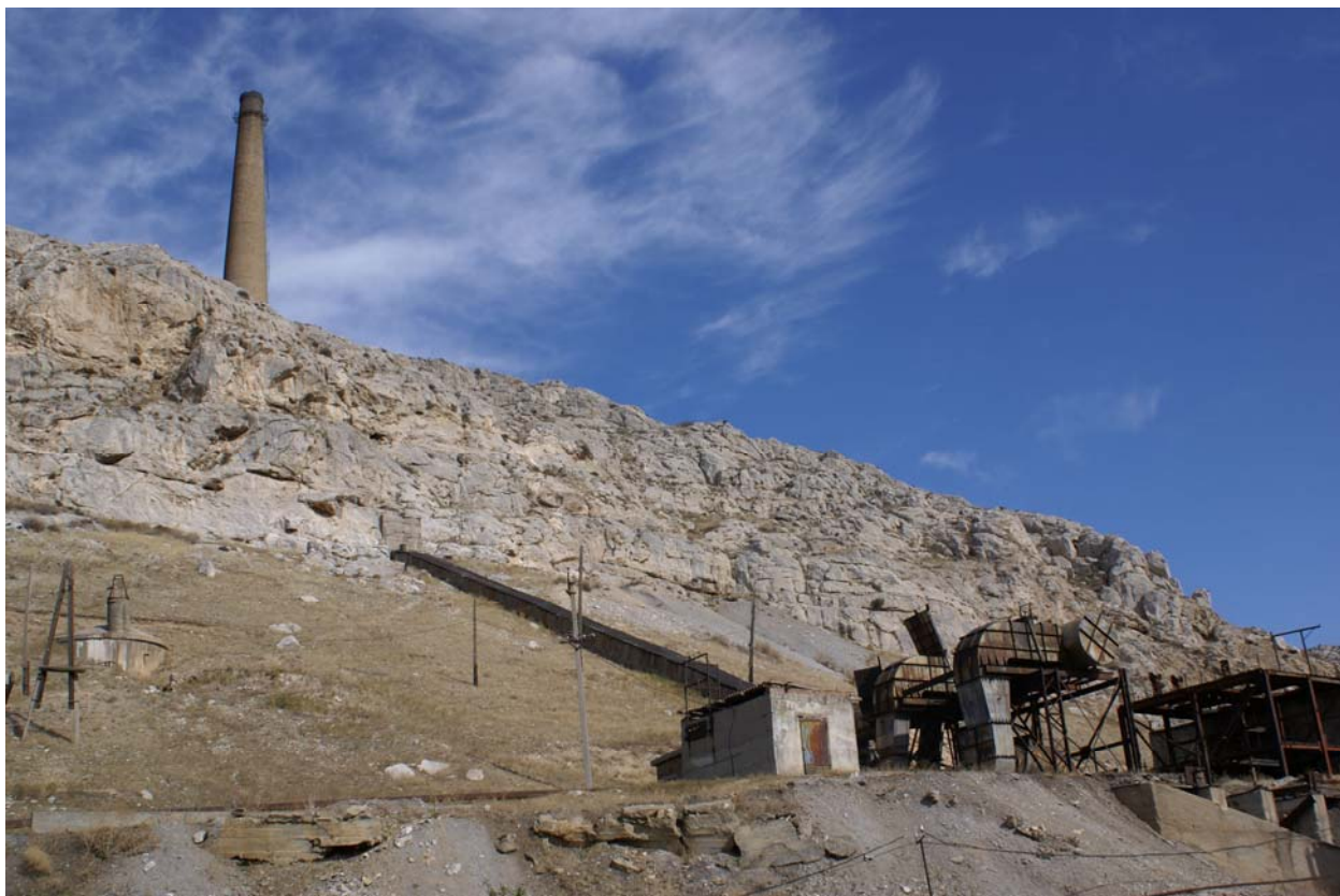
Рис. 19 Труба металлургического завода
